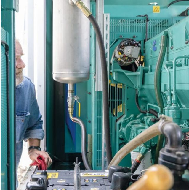
Die Funktionsfähigkeit der dieselgetriebenen Notstromanlage wird monatlich getestet.
